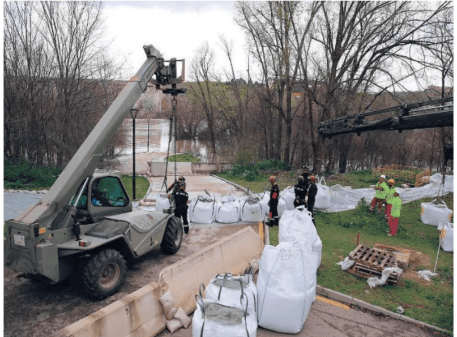
Agentes de la UME construyen un dique para proteger el Hospital de Paraplégicos de Toledo
