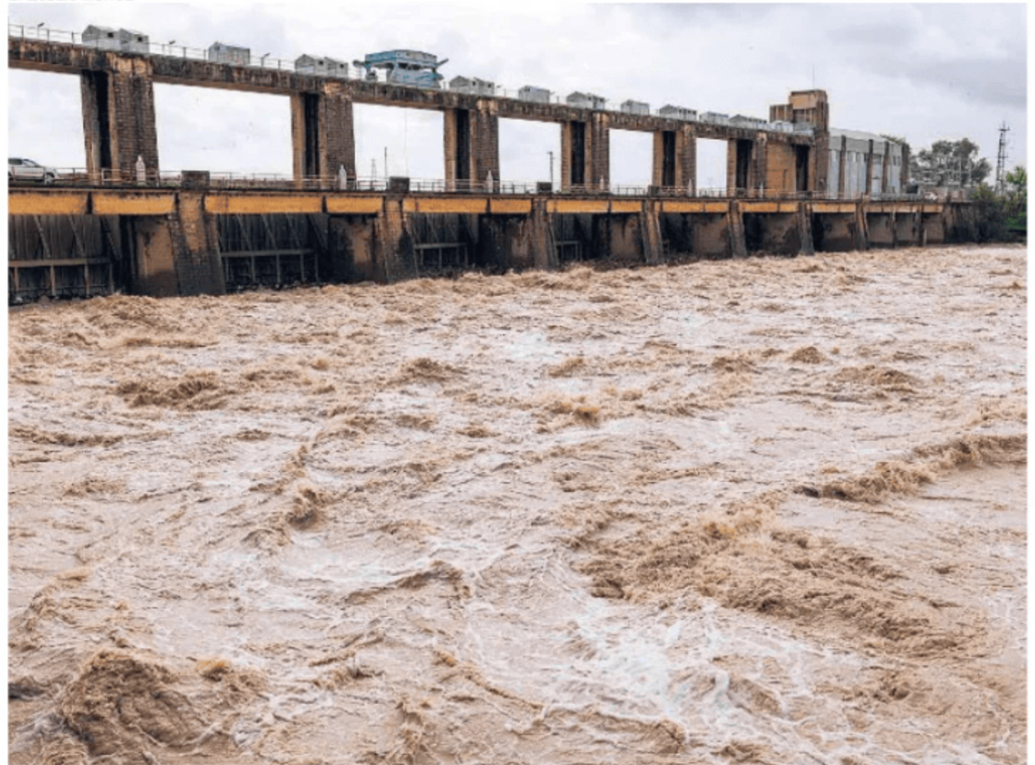
Presa situada en el cauce del Guadalquivir en la localidad sevillana de Cantillana
